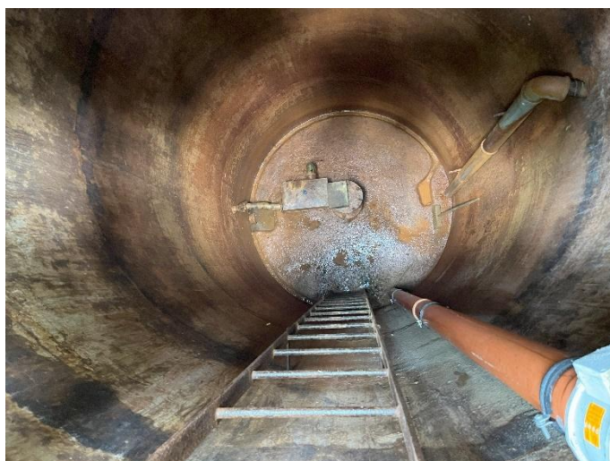
Obr. 2 Pohled na svrchní partie jímacího objektu zdroje S IV Fig. 2 View of the upper sections of the shaft tapping S IV
