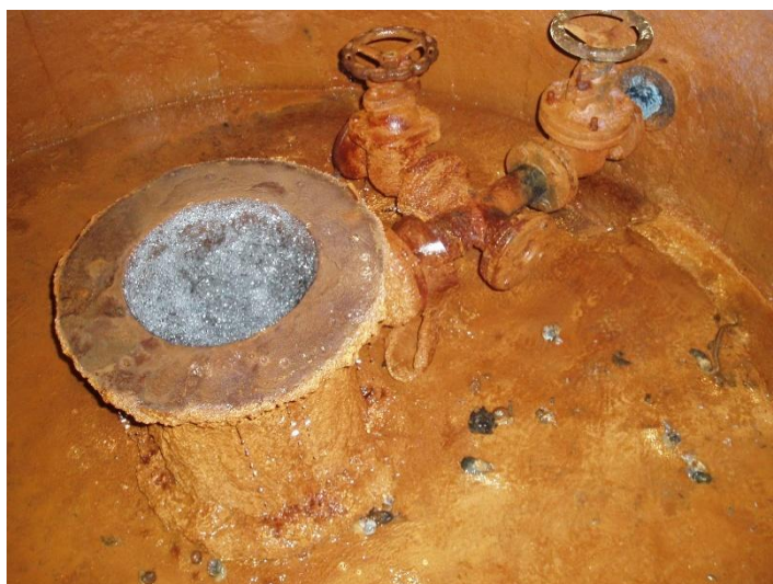
Obr. 3 Přeliv na zhlaví vrtu Sonda II
